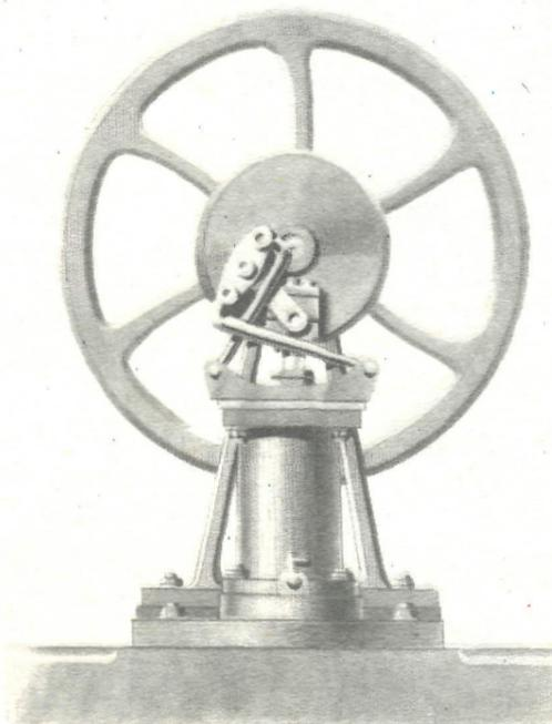
Значительное внимание Чебышев уделял исследованиям в теории механизмов. Он создал около 40 оригинальных механизмов, в том числе и паровую машину, изображенную на рисунке, а также выполнил свыше 80 модернизаций.
